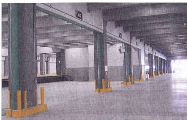
入居前の倉庫内。全長は、200mにも及ぶ。
