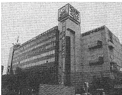
空き倉庫から複合施設に 改修された第三東運ビル
