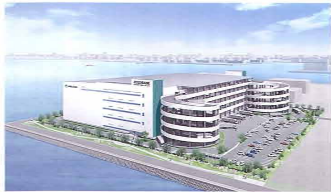
「プロロジスパーク習志野4」はマルチテナント型の仕様だが、ファッション通販のスタートトゥデイが全フロアを借り切る。完成予定は2013年8月
