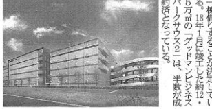
物流施設の建設現場の様子。
