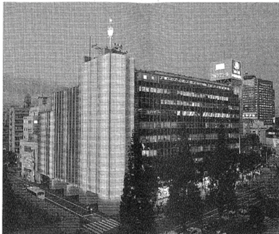
↑ 施工後。膜と照明によるコスチュームにより地味な倉庫がスタイリッシュに生まれ変わる
