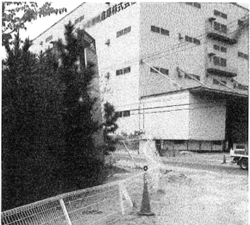
東日本大震災の影響による物流施設（千葉県浦安市）の液状化被害の様子。地震の影響により、物流施設の柵が半分埋まっている
