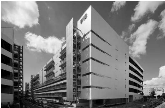
TRC(東京流通センター)物流ビル新A棟
